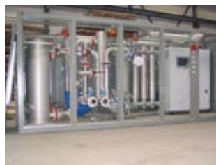
TCR in aanbouw
