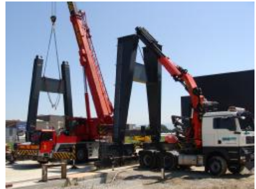
Aufstellen der beiden Portalstützen
