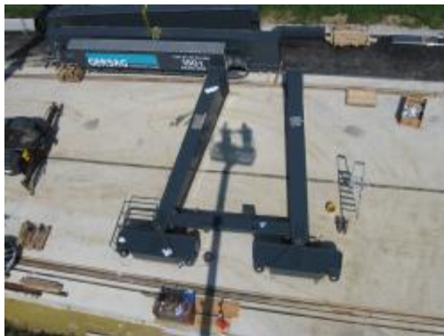
Vormontage der Stützen am Boden
