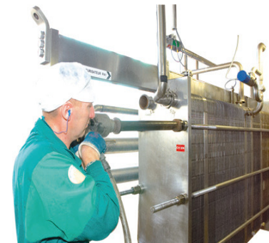
Interventie uitgevoerd op een platenwarmtewisselaar
