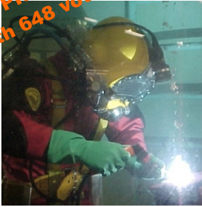
Onderwaterlassen door Rob Bos voor scriptie LPI van RMBos
